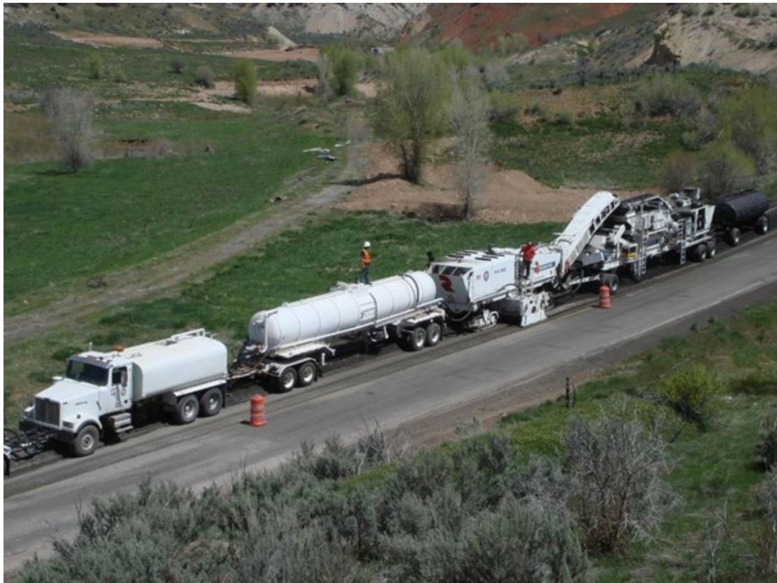
图16-就地冷再生，部分深度，多单元设备组
