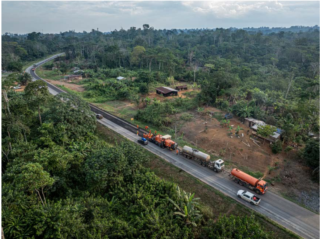
图31 - 使用乳化沥青进行路面冷再生
