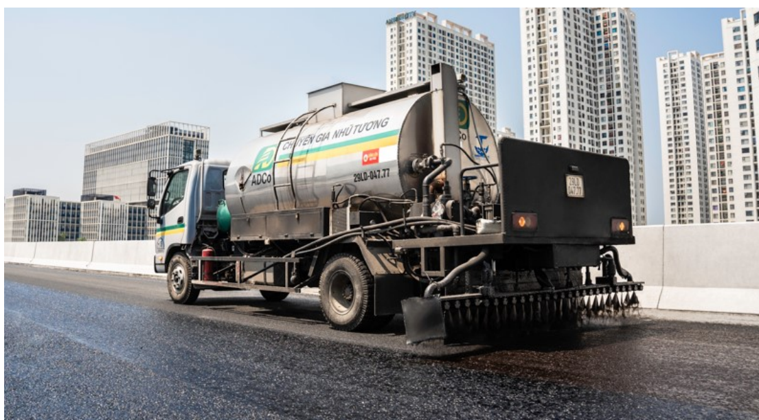
图2-粘层施工
