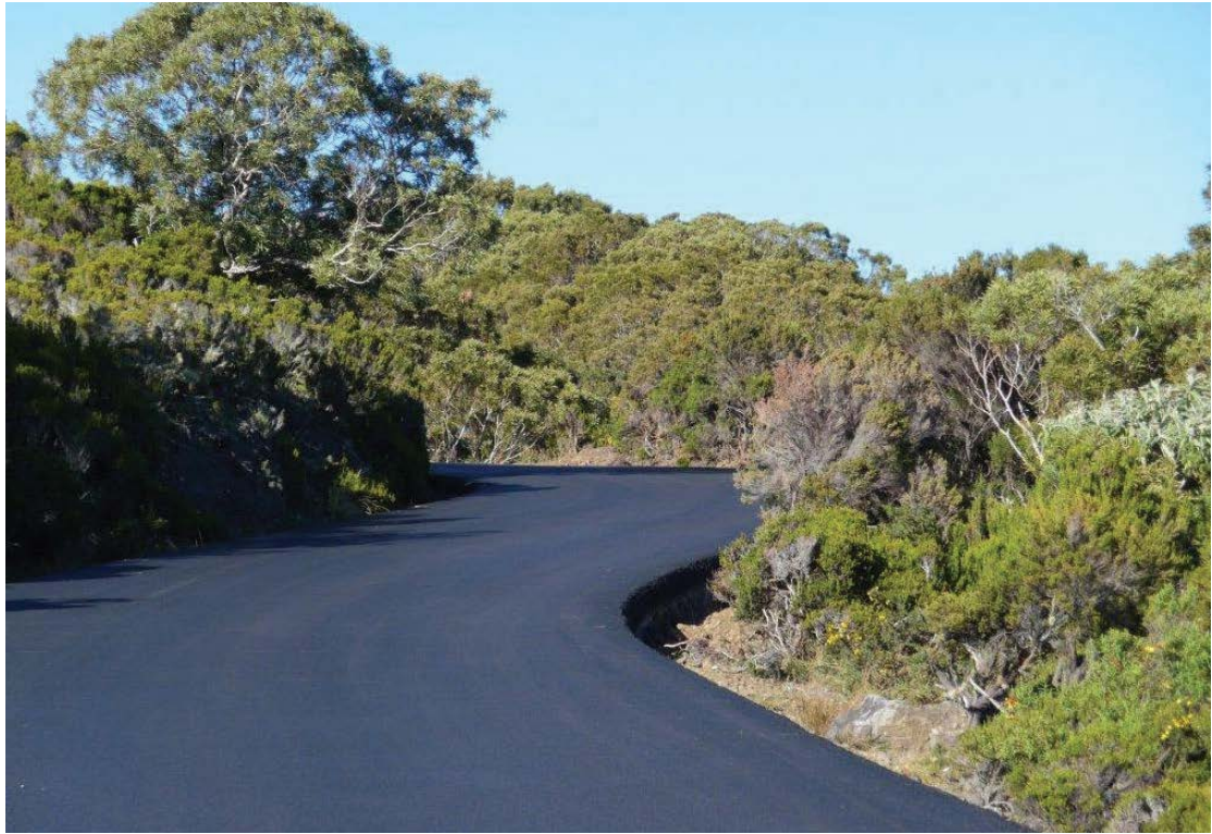
图11-乳化沥青碎石道路
