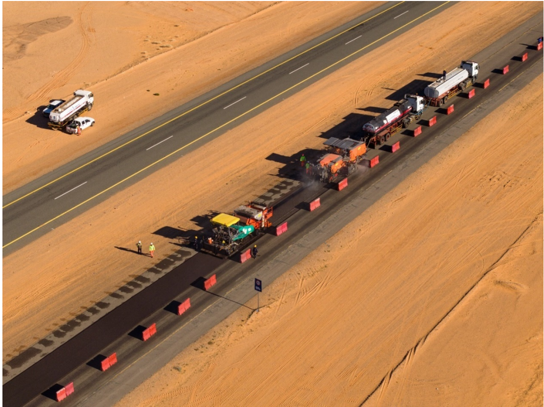
图22-就地冷再生，沙特阿拉伯
