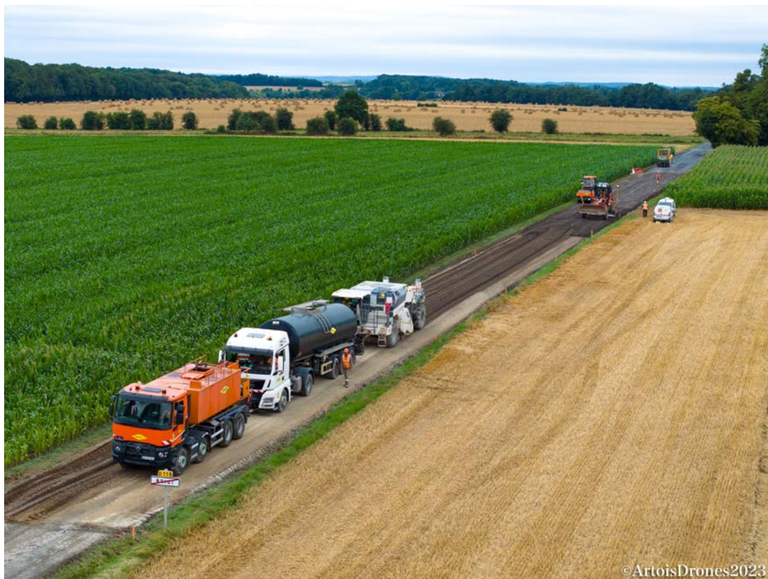
图30 - 使用乳化沥青进行道路加固
