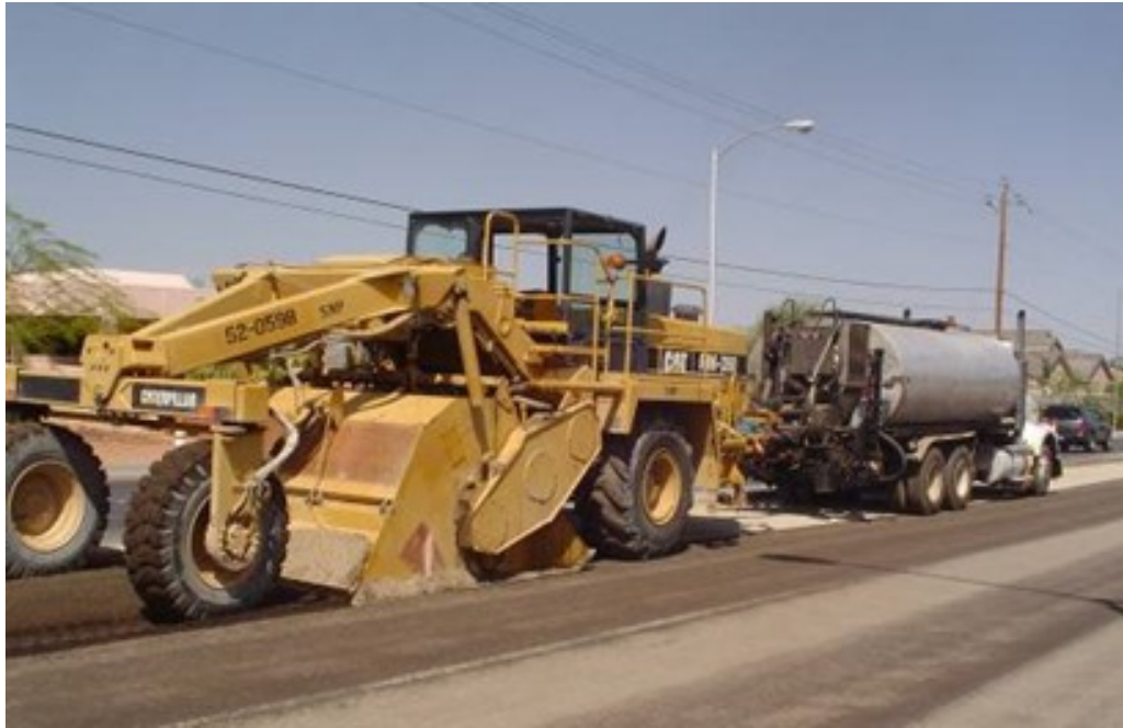
图19-使用乳化沥青进行基层稳定
