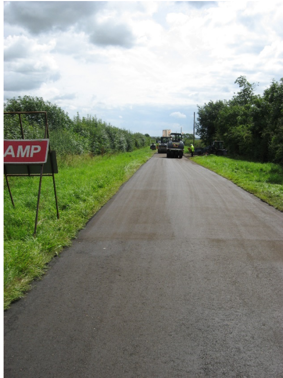
图29-CCPR最终路面
