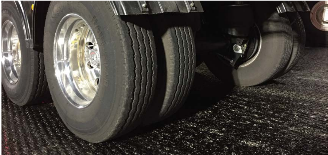
图3-不粘轮粘层-粘层不会被施工车辆轮胎粘附
