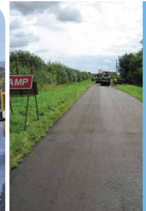
Figura 29 - Acabado final del pavimento tras emplear la técnica de CCPR
