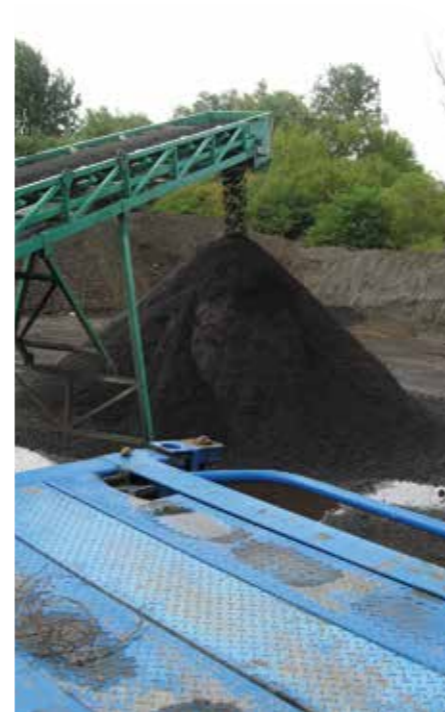
Figura 27 - Fabricación empleando CCPR
