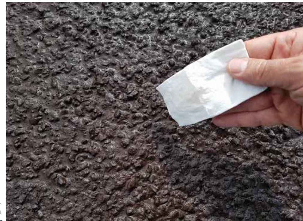
Superior: Figura 14 - Tratamiento superficial de riego con gravilla que emplea emulsión modificada con polímero.
