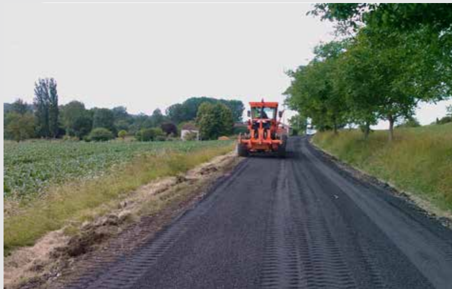
Figura 10 - Aplicación de grava-emulsión
