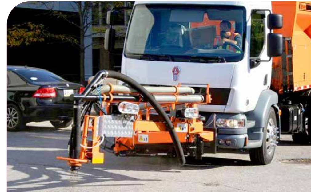
Superior: Figura 19 - Establización de suelos con emulsión Inferior: Figura 20 - Bacheo por inyección
