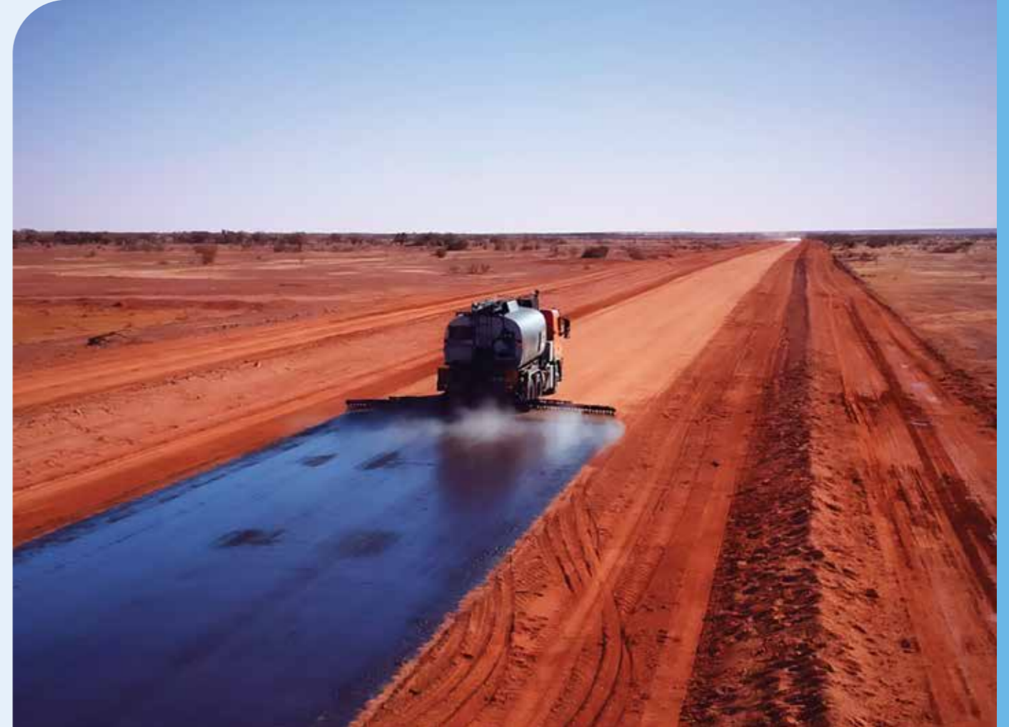
Figura 1 – Aplicación de un riego de imprimación.
