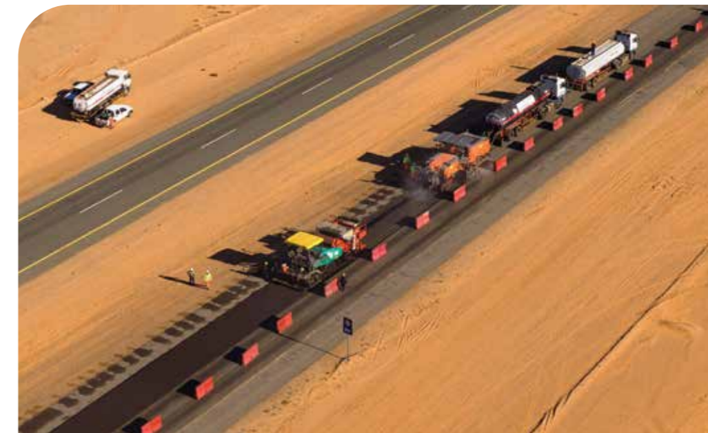
Superior: Figura 21 - Reutilización en frío in-situ, Francia
