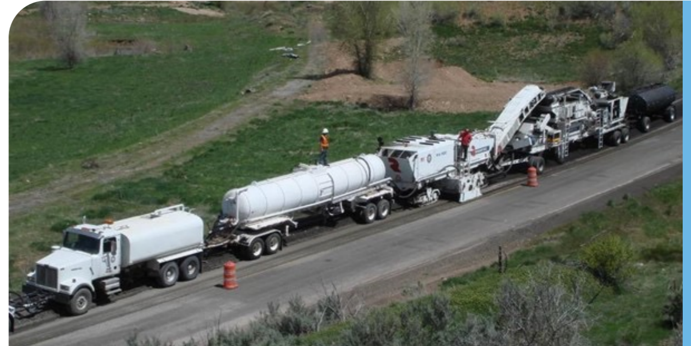
Figura 16 - Reutilización en frío in-situ, de profundidad parcial utilizando un tren multi-unidad
