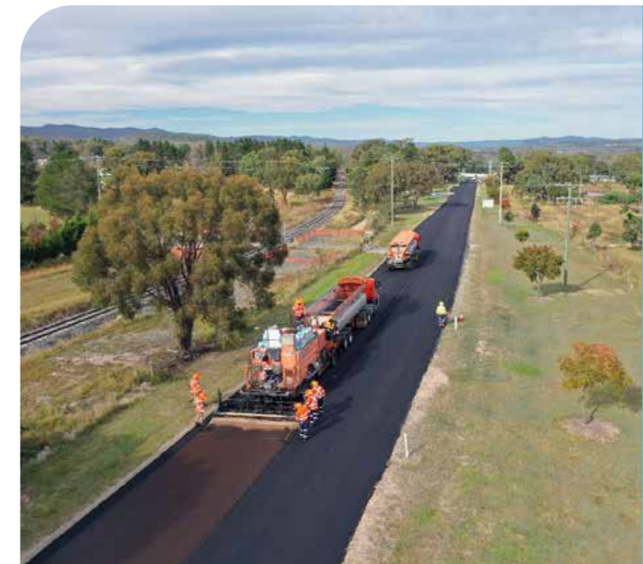
Figura 9 - Aplicación de un microaglomerado en frío
