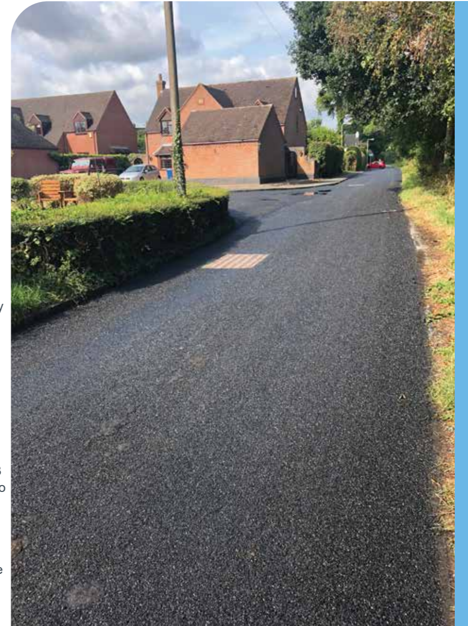
Figura 5 - Riego de humeo en superficie en un tramo rural
