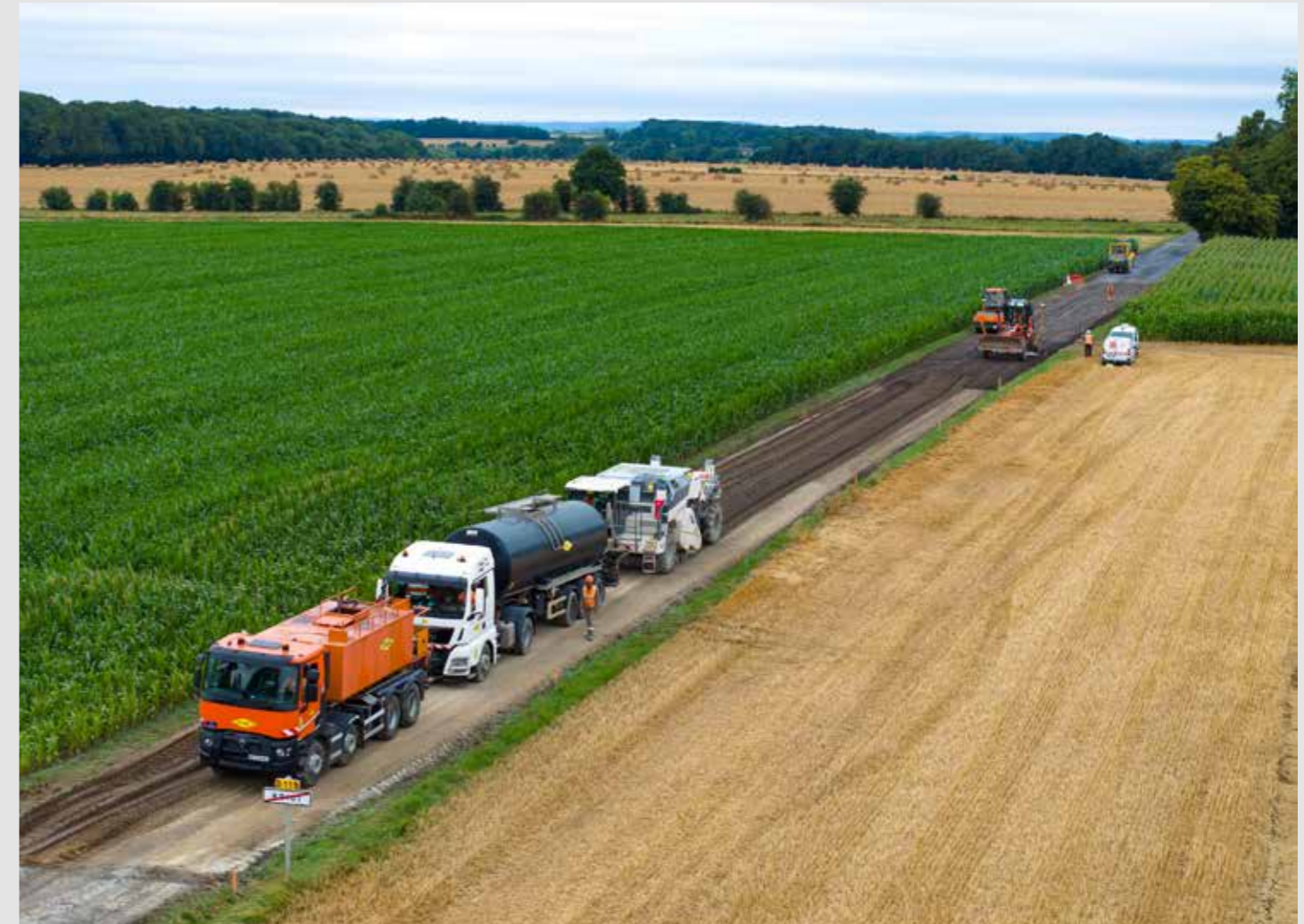
Figure 30 - Estabilización de bases con emulsión
