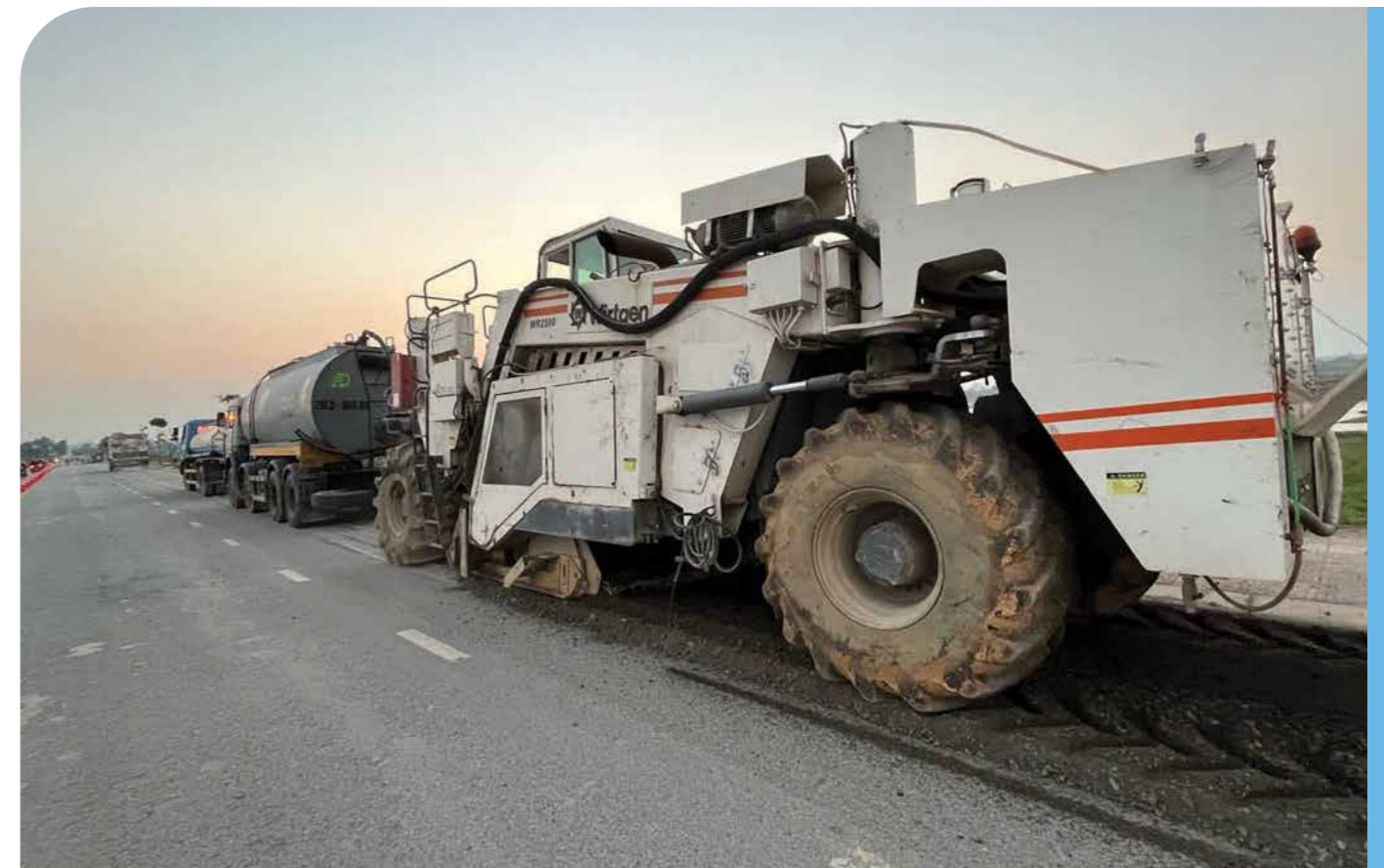
Figura 23 -Reutilización en frío in-situ. Vietnam
