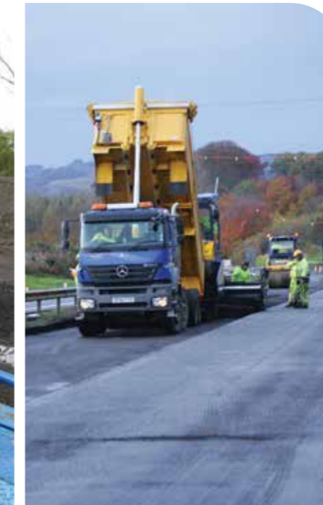
Figura 28 - Aplicación empleando CCPR
