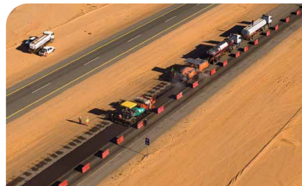
Haut: Figure 21 - Retraitement en place à froid (France)
