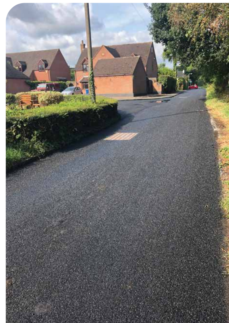
Figure 5 - « Fog seal » sur un enduit superficiel en milieu rural
