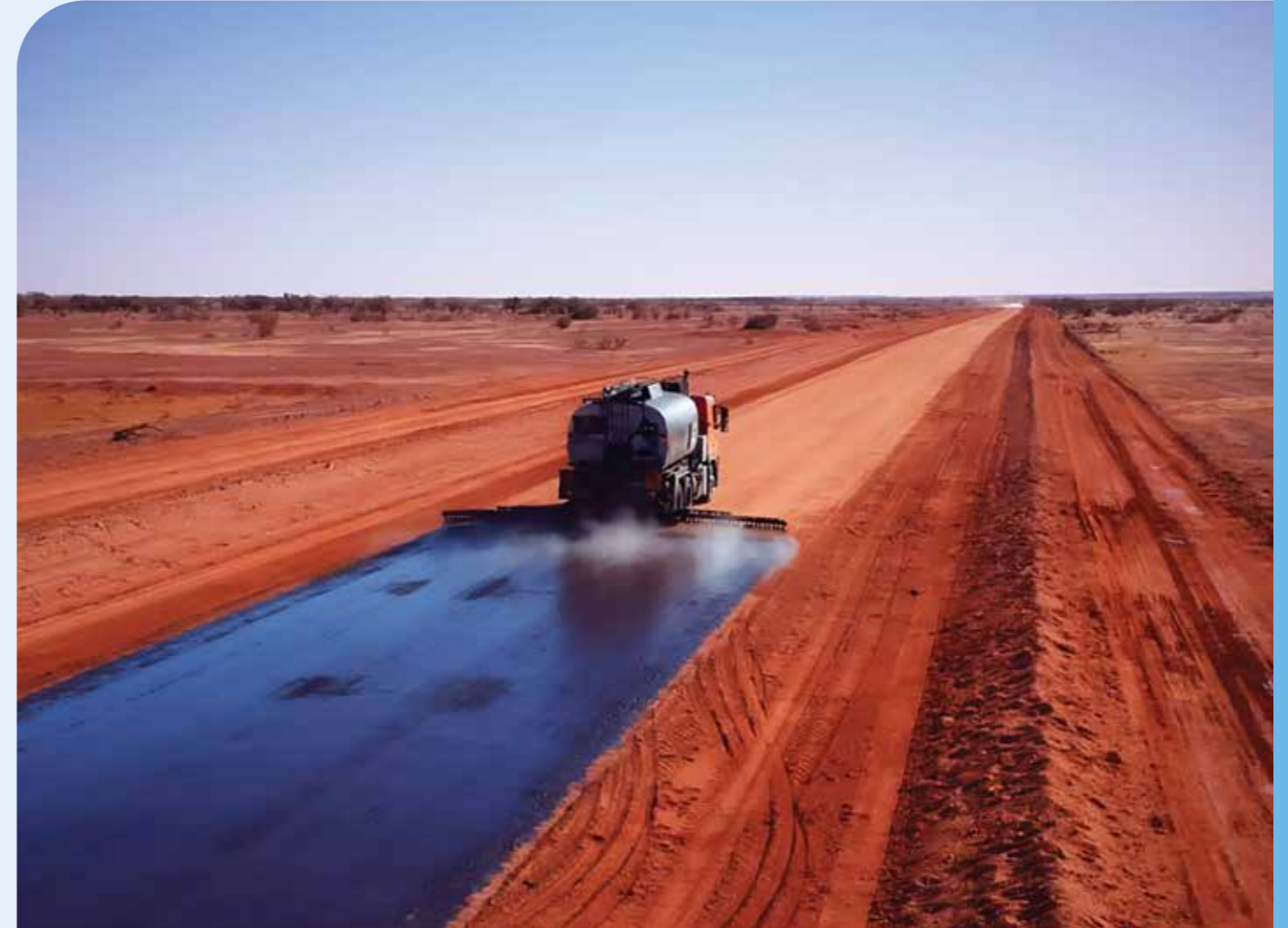
Figure 1 – Application d'une couche d'imprégnation
