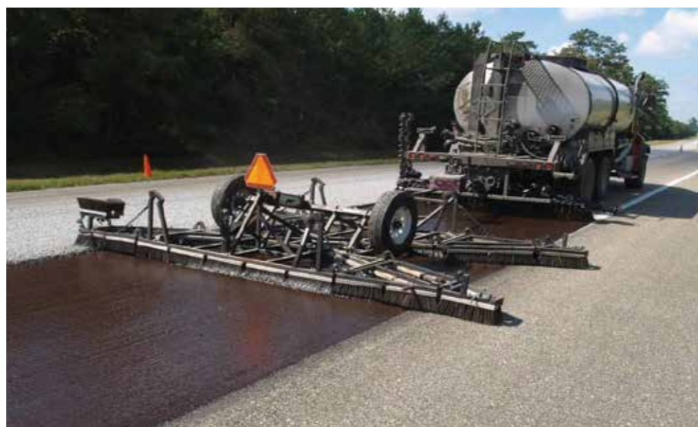
Haut: Figure 6 - Gravillonnage sur un enduit superficiel Bas: Figure 7: Aperçu du « scrub seal »
