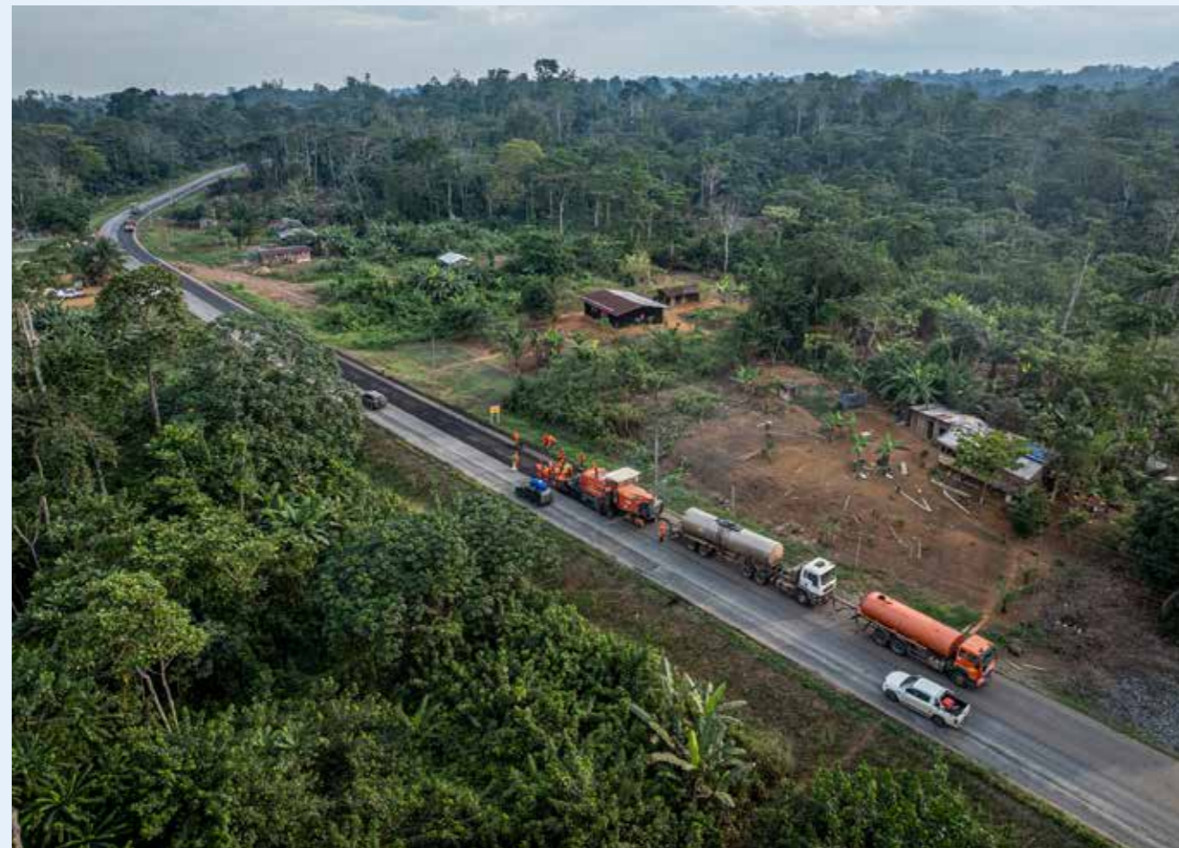
Figure 32 - Recyclage en place à froid d'une chaussée à l'émulsion de bitume
