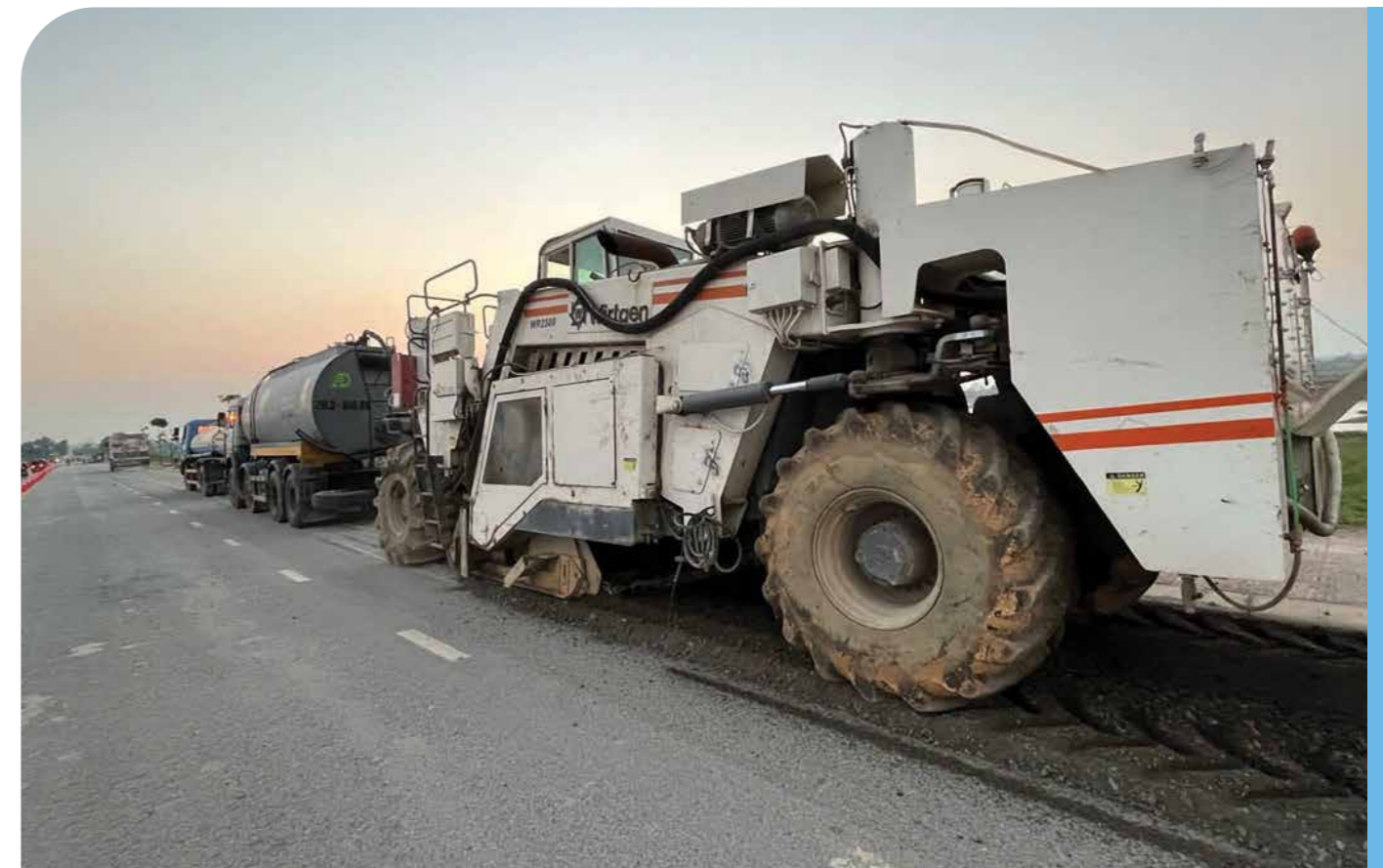
Figure 23 - Retraitement en place à froid (Vietnam)
