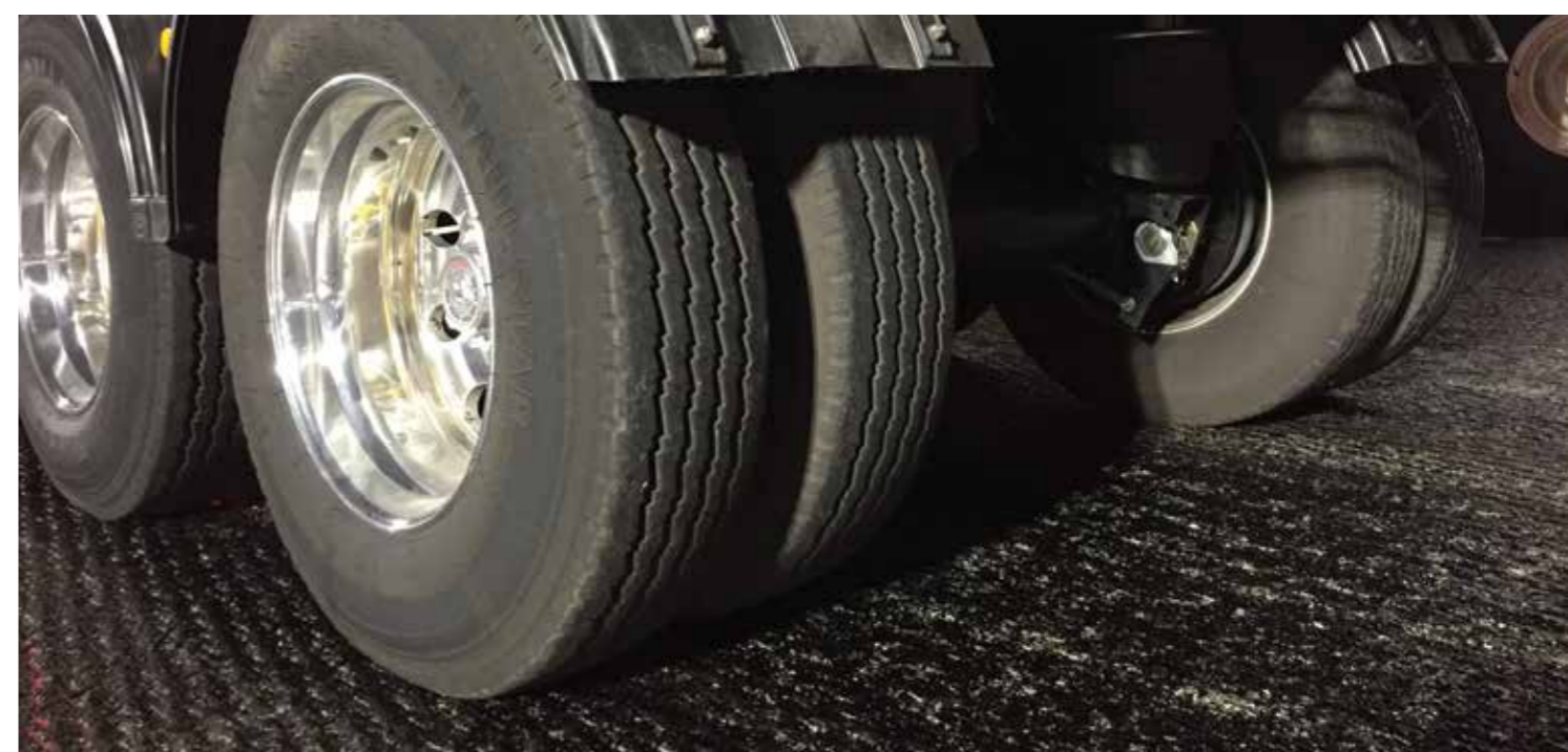
Haut: Figure 2 - Application d'une couche d'accrochage
