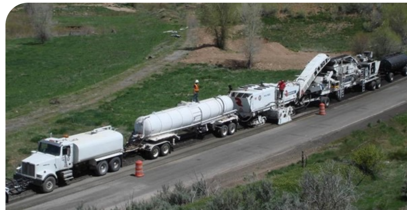
Figure 16 - Retraitement en place à froid, en profondeur partielle, avec un train composé de plusieurs unités
