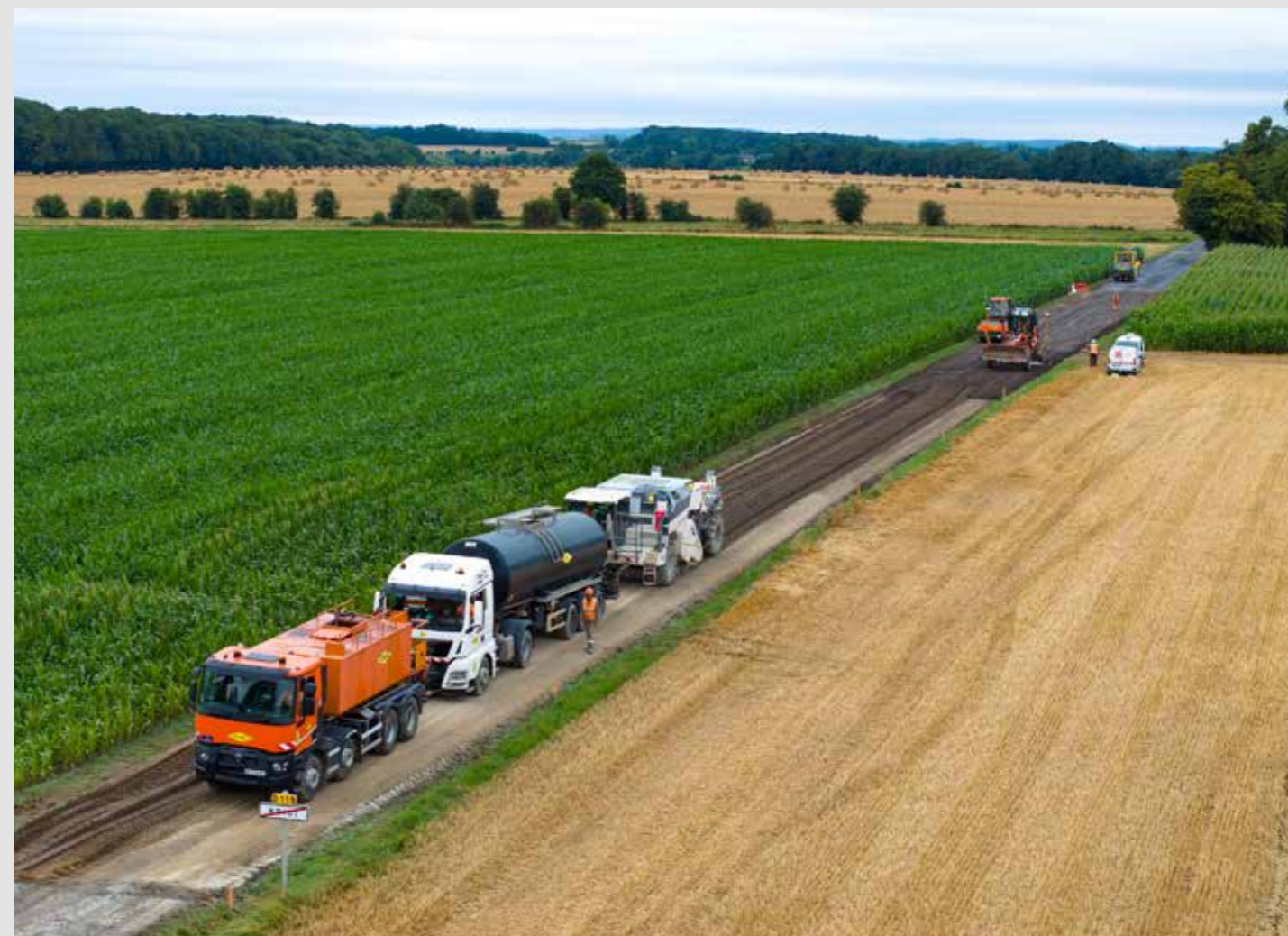
Figure 30 - Stabilisation d'une route à l'émulsion de bitume
