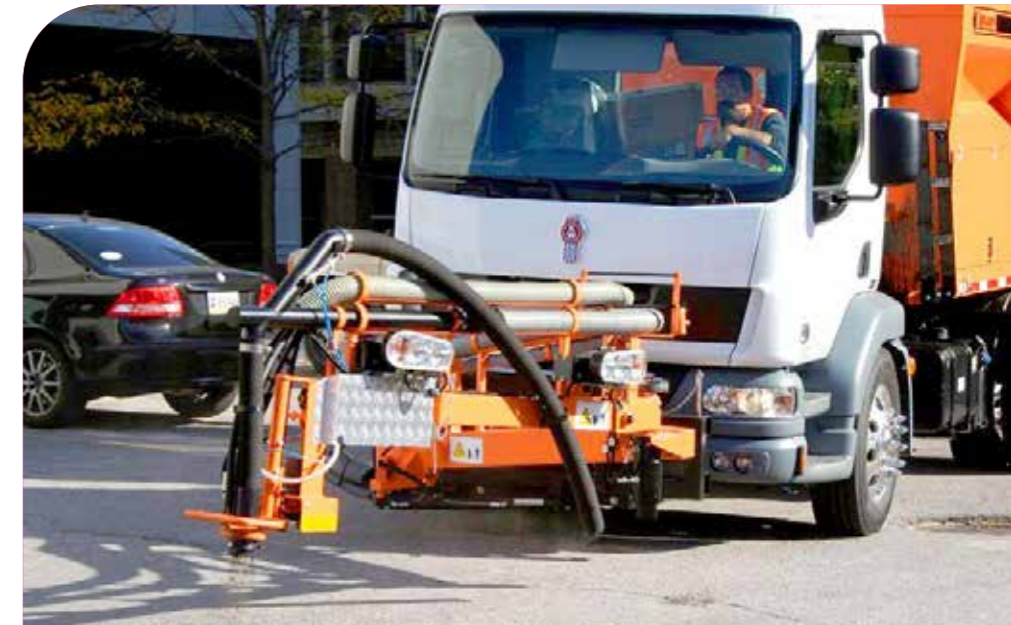
Haut: Figure 19 - Stabilisation de la fondation à l'émulsion Bas: Figure 20 - Enrobeur-projeteur
