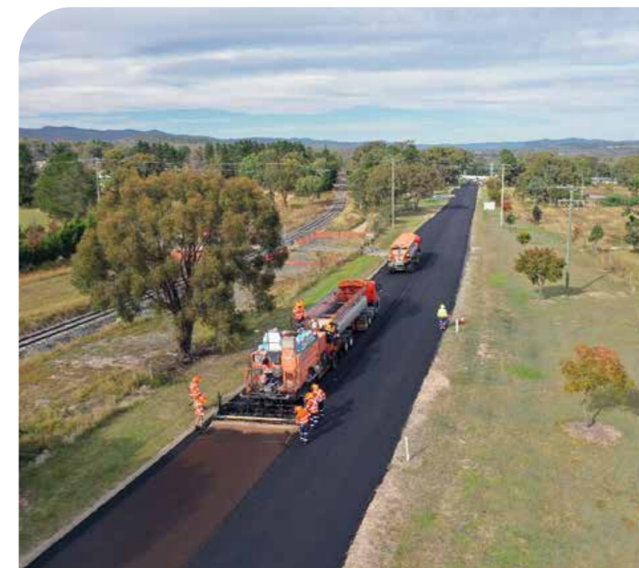
Figure 9 - Application d'un enrobé coulé à froid
