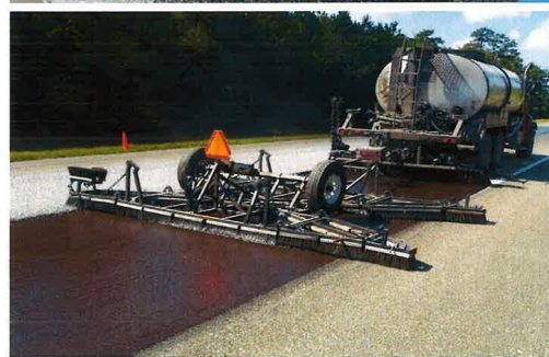
図-7 スクラブシールの施工状況
