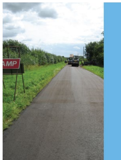
図-29 CCPR 施工後の路面
