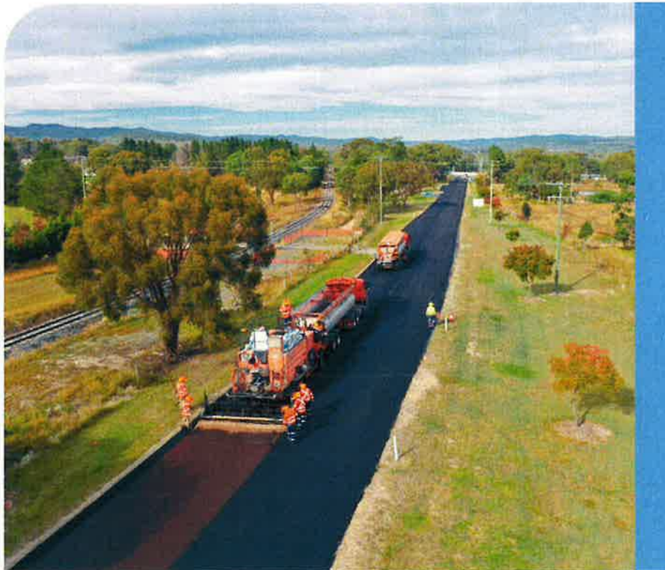
図-9 マイクロサーフェシングの施工状況
