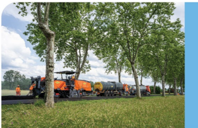
図-21 フランスにおける 常温路上表層再生工法
