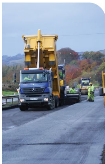
図-28 CCPR の施工
