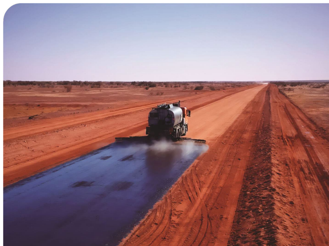
図-1 プライムコートの施工
