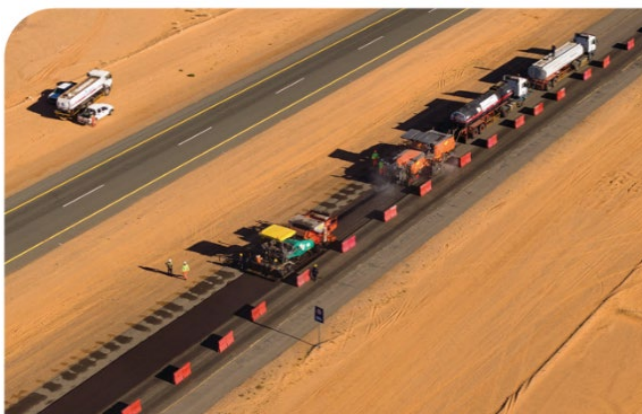
図-22 サウジアラビアにおける 常温路上表層再生工法
