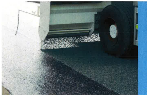
図-6 チップシールの施工状況
