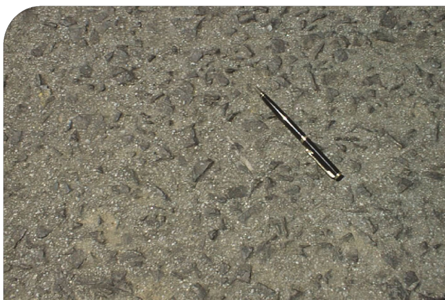
図-13 南アフリカでチップシールを実施した際の仕上がり面
