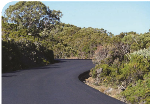
図-11 グラベルエマルジョン施工後
