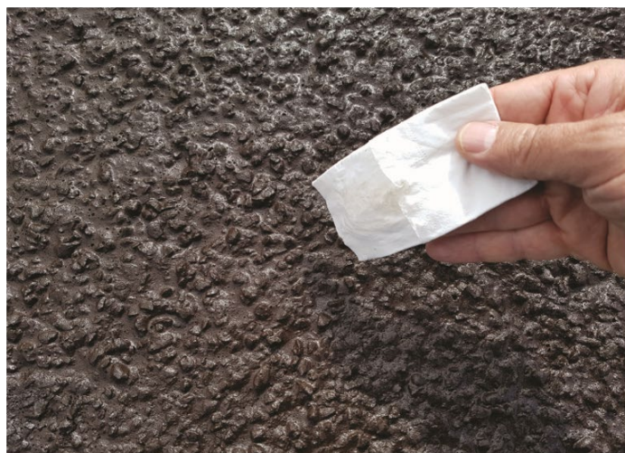
図-15 速分解型乳剤を用いた マイクロサーフェシング
