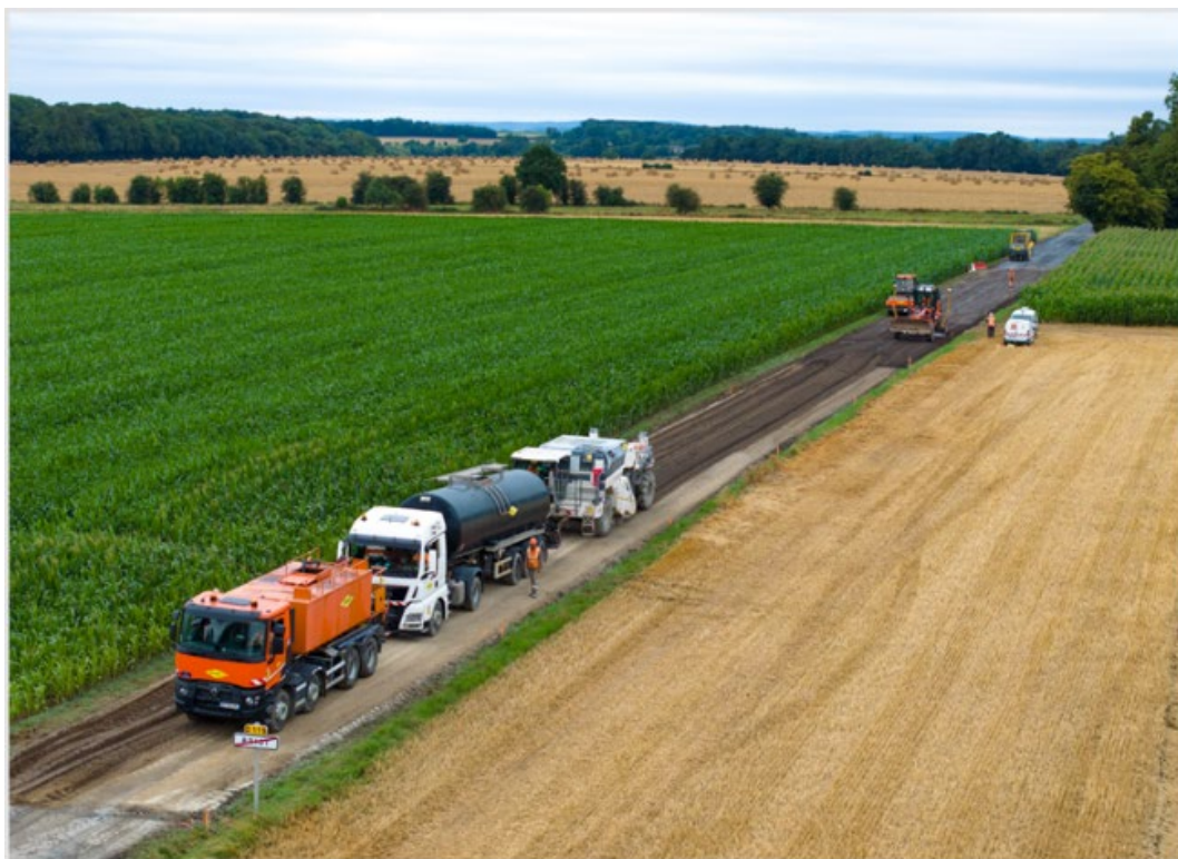
図-30 乳剤による路盤安定化
