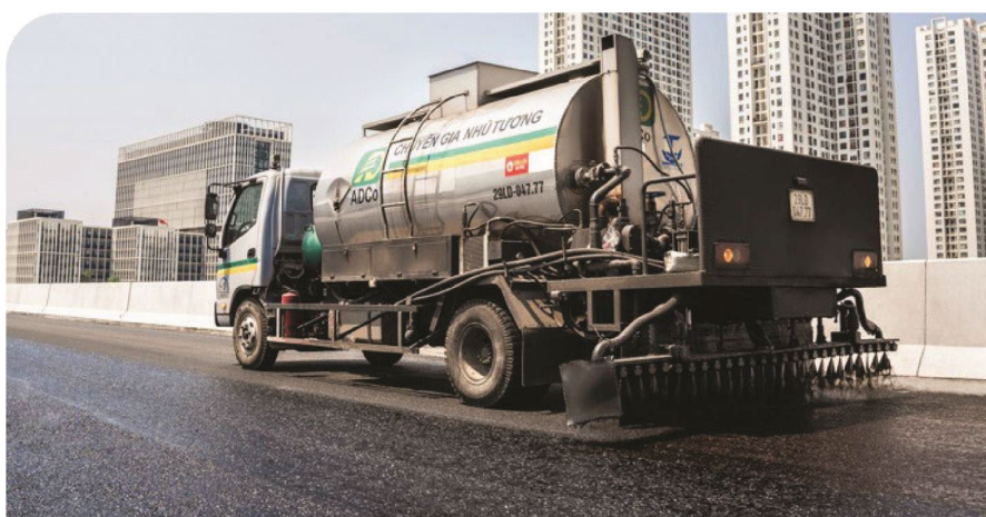
図-2 タックコートの施工状況
