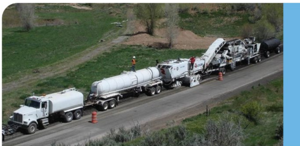
図-16 常温路上表層再生工法、ユニット施工車両
