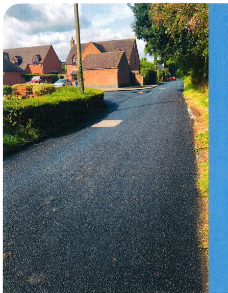
図-5 農村の環境で施工されたフォグシール
