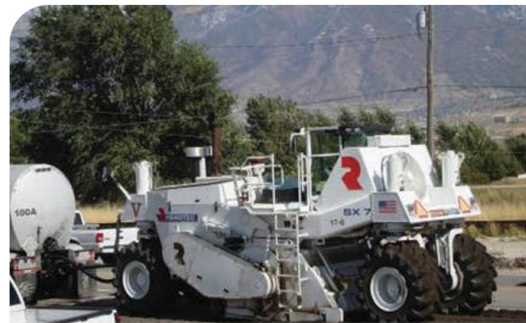
図-18 路上路盤再生工法
