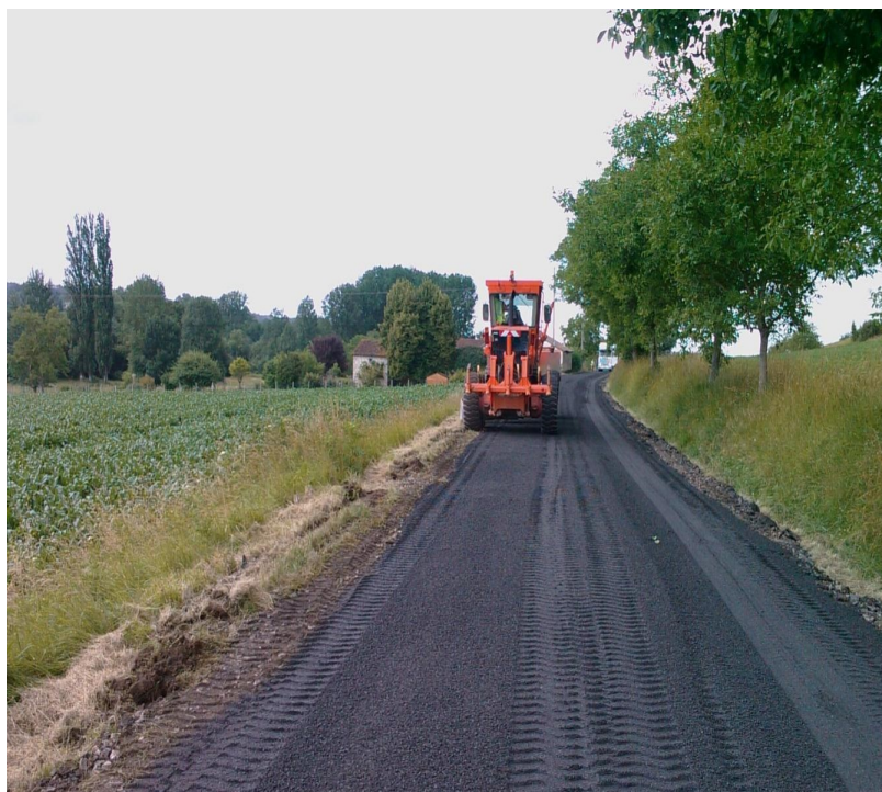
図-10 グラベルエマルジョンの施工状況
