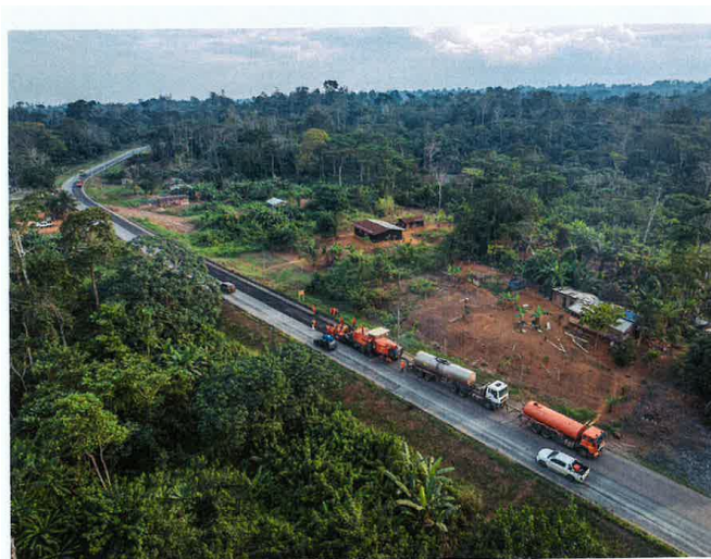
図-32 乳剤を用いた常温路上表層再生工法
